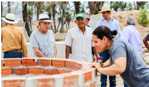
Visita à barragem construída por meio do convênio Sertão Empreendedor
